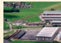
Mayr-Melnhof Holz Gaishorn am See (Holzweiterverarbeitung)
