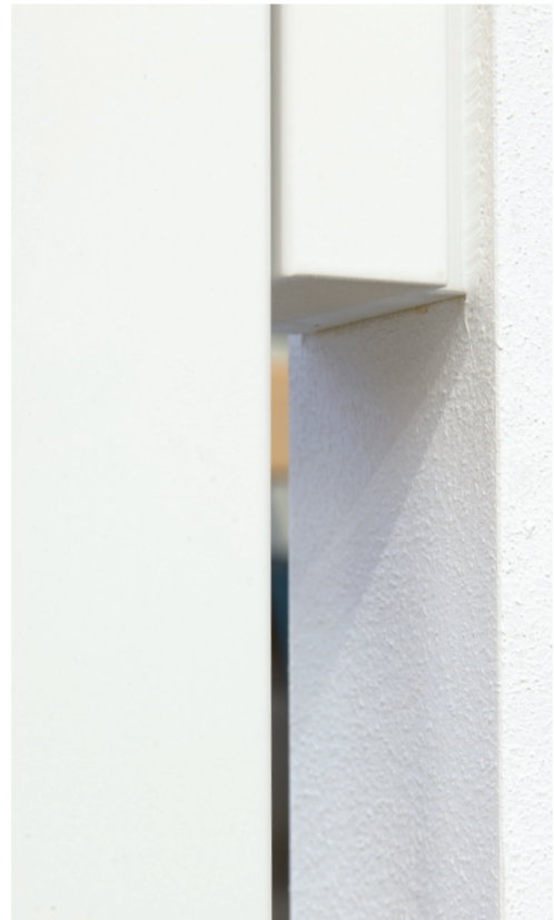
Detail: Blockzarge auf verputzter Laibung
