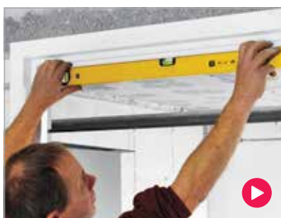
Montage der Zarge von Multifunktions-Stahltüren
