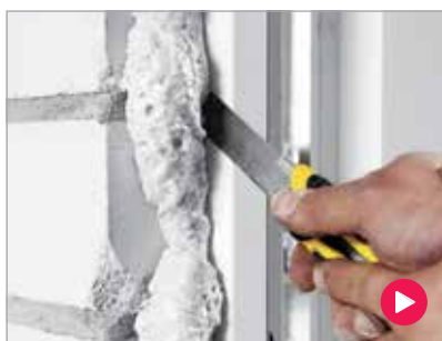
Herstellen des Wandanschlusses
