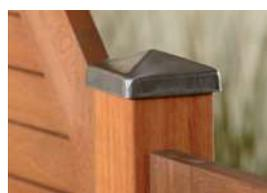
Konstruktiver Holzschutz: Schützen Sie die schichtverleimten Hartholzpfeosten zwingend mit Kapfen aus Edelstahl, Seite 21.
