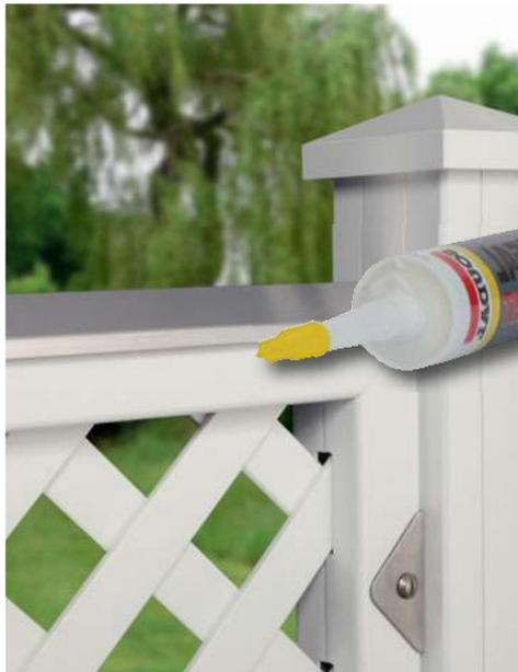
Designaufsatz Alu mit MS-Polymer-Kleber (1398) befestigen.
