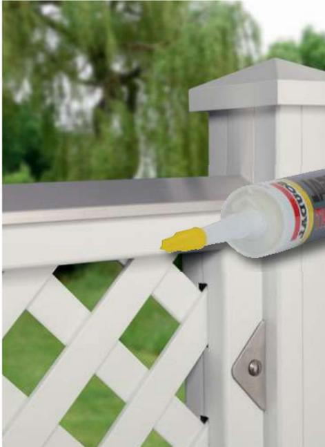
Designaufsatz Alu mit MS-Polymer-Kleber (1398) befestigen.
