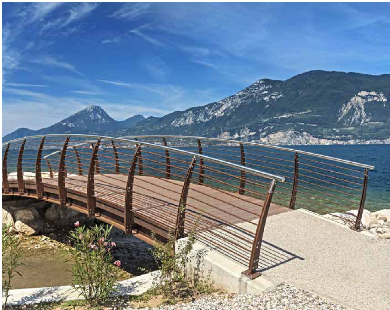
Brücke am Gardasee, DIE KOMPAKTE in Braun
