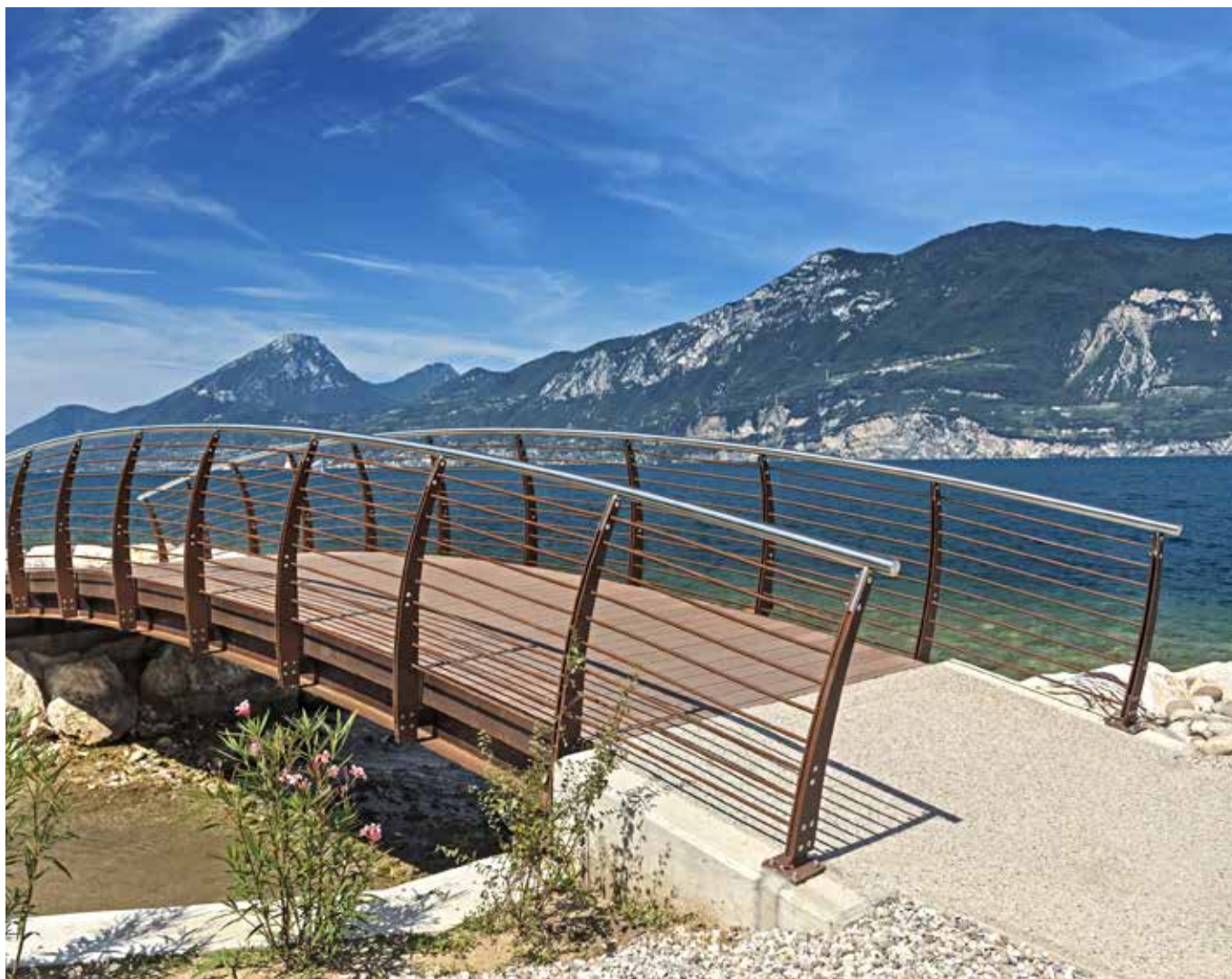
Brücke am Gardasee, DIE KOMPAKTE in Braun
