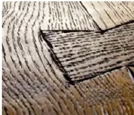
ausgearbeitete Längsrisse und Schwalbenschwanztechnik
